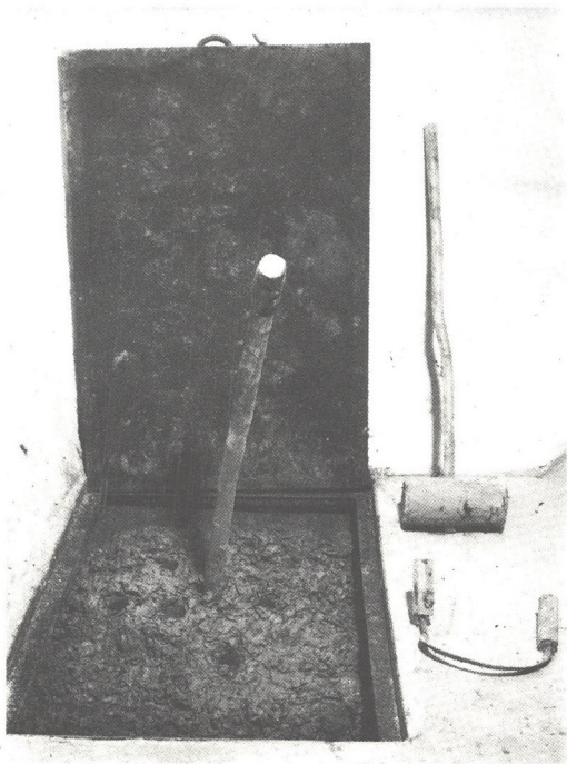
Обробка і зберігання глини: а) яма для глини; б) дерев'яна палка, якою проколюють глину; в) дерев'яний молот, або довбня; г) струг для різання глини
