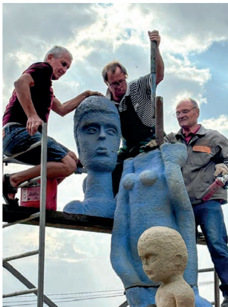
Сергій Радько, Сергій Кульбака, Борис Безрук під час монтажу скульптури Яни Петрової
