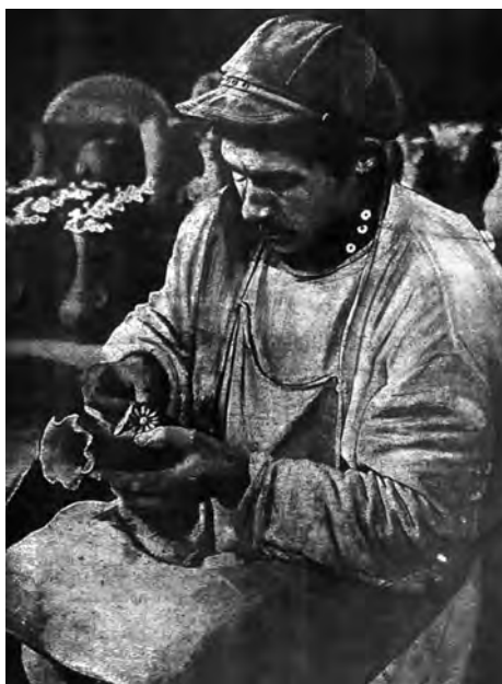
✿ Наліплювання декоративного елемента (квітка) на поверхню вази. Макарово-ярівська керамічна кустарно-промислова школа (?). Майстри: Михайло Кирячок – (?), 1, невідомий – 2. Макарів Яр, Луганщина (?). 1930 – початок 1931 (?). Автор фото невідомий. Репринти [143, с.45, рис.32, с.47, рис.38]
