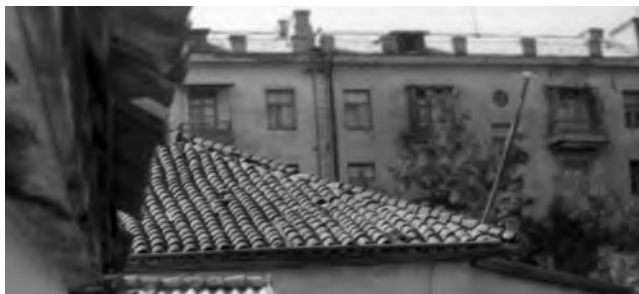
❖ Татарська («совкова») черепиця (дахівка) на старих будинках, виготовлена місцевими гончарями*. Глина, гончарний круг, теракота, 32х17 см («Ворошиловград – черепиця 32х17 см. 1-2 см глибиною**»). Луганськ. 1910–1920-ті роки. Фото Юрія Лашука 1973 року [70, каталог негатеки, зошит «А–Б», с.17; негатека, П-36:20, 25, 21]. Публікуються вперше
