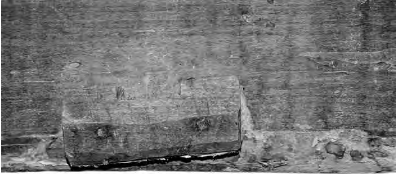
■ Дерев'яний брусок з вирізом для вставляння дерев'яних жердин, на які ставили п'ятра. Колишня хата малобудищанського гончаря Якова Герасименка. Малі Будища, Полтавщина. 29.09.2005. Фото Олесь Пошивайло. Національний музей-заповідник українського гончарства в Опішному, Національний архів українського гончарства. Публікується вперше
